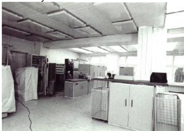
Začiatok prác na kabeláži dodaného počítača.
