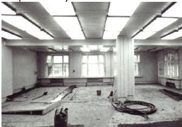
Rekonštrukčné práce v budove SPŠE, príprava sály na umiestnenie počítača EC 1021.
